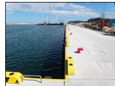
岸壁の耐震強化
