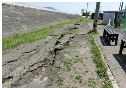
堤体の液状化
