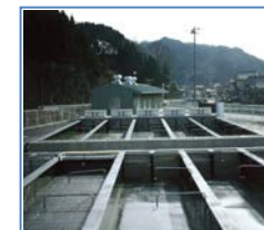
さけ・ます 種苗生産施設
