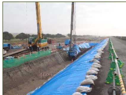
鋼矢板打設による耐震対策
